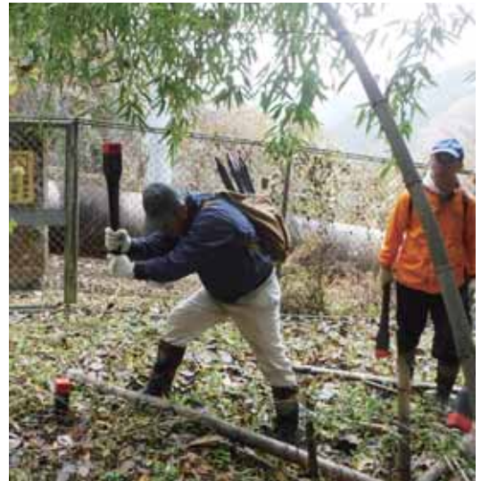
稲武・川手地区の杭入れのようす
