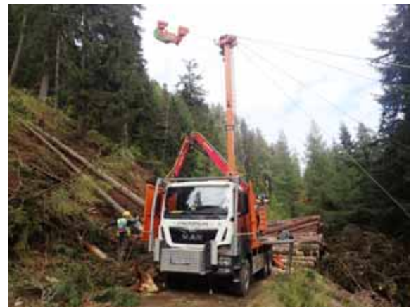
↑タワーヤード
