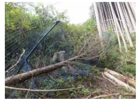
倒木による柵の破損
